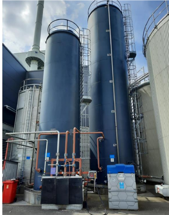
Figur 6 Cisterner med diesel, eldningsolja och ammoniak.
