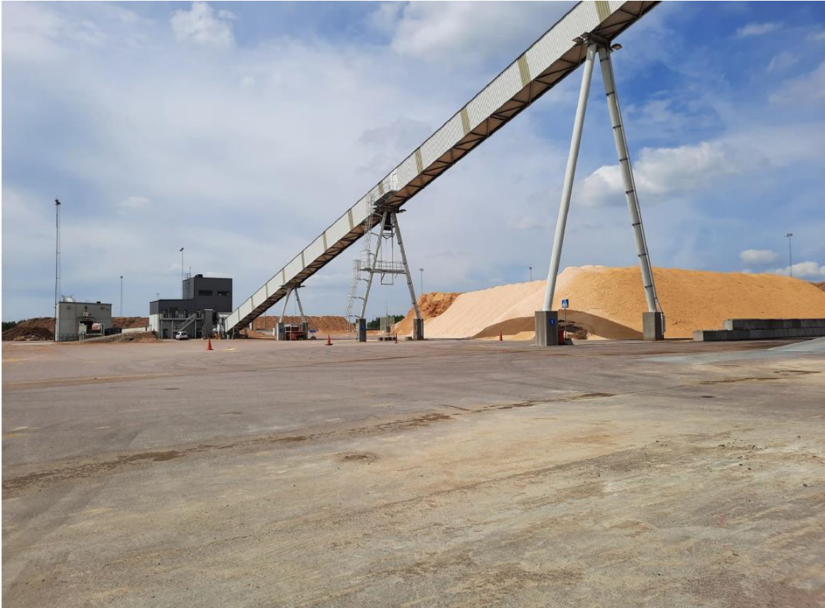
Figur 8 Lagringsytor för flis samt transportband till panncentral.
