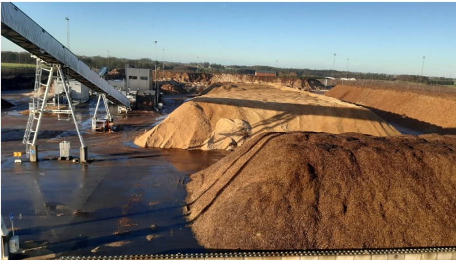
Figur 6-8 Bränslelagring vid befintlig verksamhet. På bilden syns lagerytan, sällhuset med skivsåll, bandmagneter och rejektkross samt transportbandet till pannan. Fotograferat i juni 2022.
