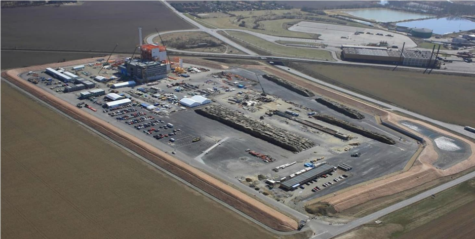
Figur 4-2. Foto av Örtoftaverket från 2013 som visar vällen som är anlagd runt området. Fotot är tillhandahållet av Krafrtringen AB.
