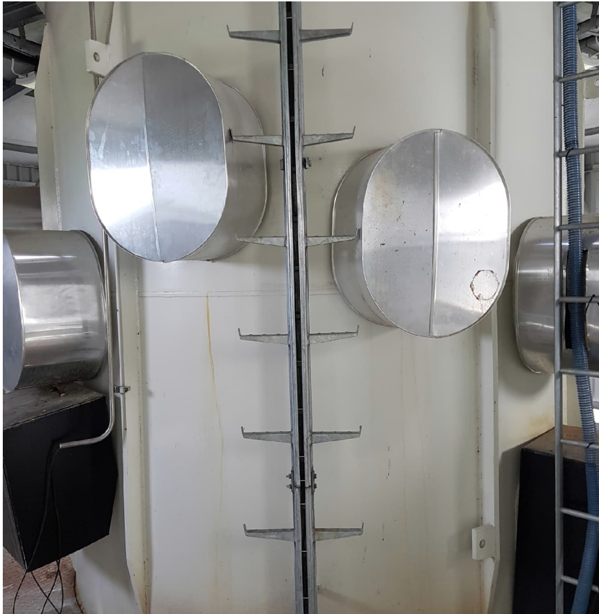
Figur 7-3 Öppningar i skorsten vid befintlig anläggning för luftmätningar. Fotograferat juni 2022.
