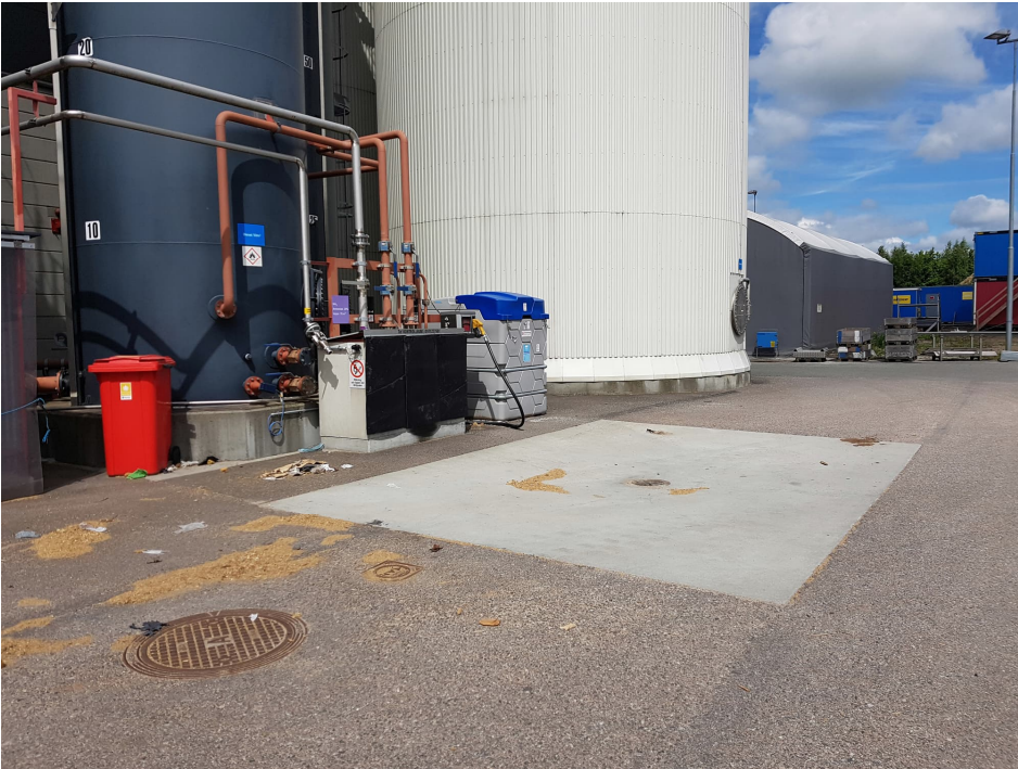
Figur 6-6 Lossningsplatta för bland annat ammoniak vid befintlig anläggning. Fotograferat juni 2022.
