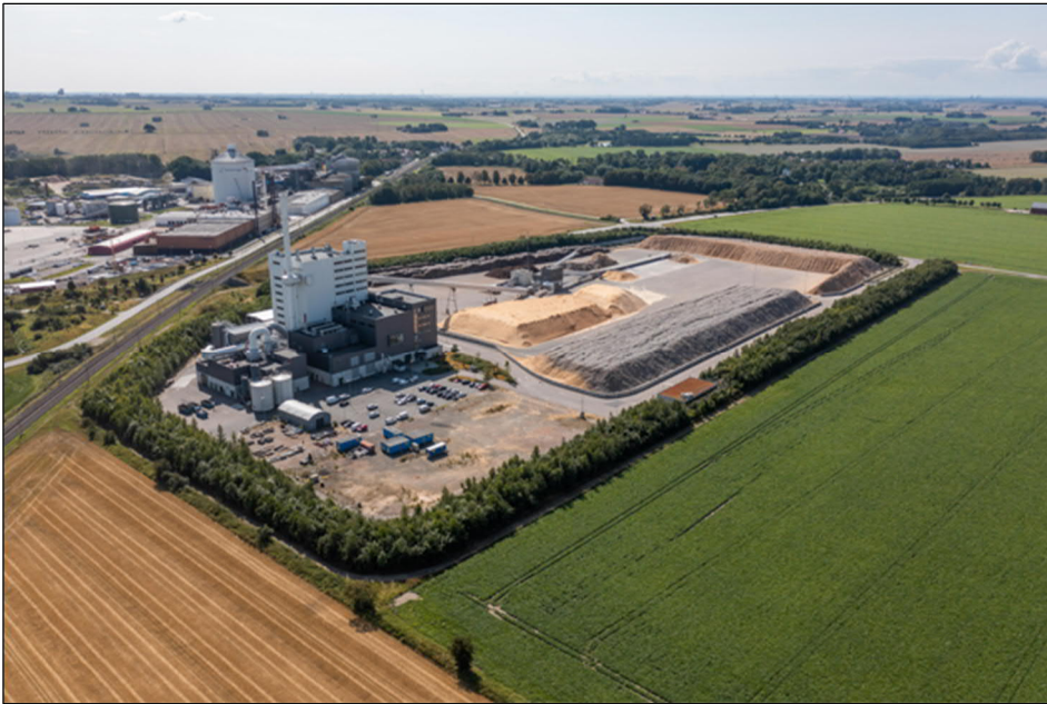
Figur 1 Drönarbild över befintlig anläggning, vy söderut. Bilden är tagen 2021.
